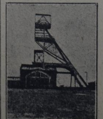
TORRE DE CEMENTO ARMADO, CON SUS POLEAS VISIBLES, PARA EXTRAER EL CARBÓN DE LAS MINAS
